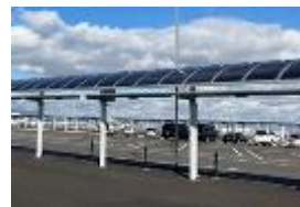
ヘロプスカイト太陽電池の万博西ゲートでのバスシェルターへの設置
