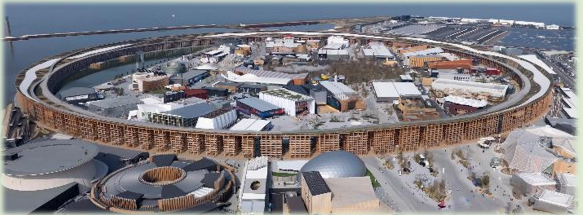
円周約2km、直径(内径)約610m、高さ内側12m・外側20m、幅30m
