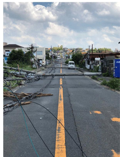
図 1-18 2018 年台風第 21 号による 電柱倒壊（泉南市） 出典：令和元年版防災白書
