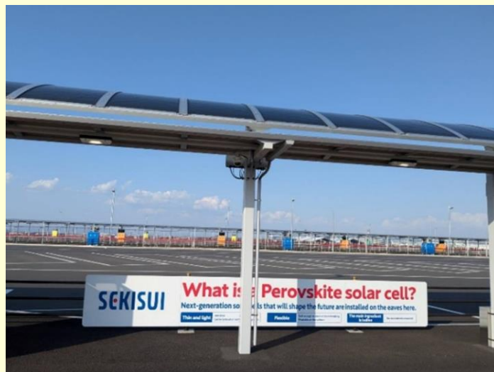
ペロブスカイト太陽電池の 万博西ゲートでのバスシェルター設置状況
