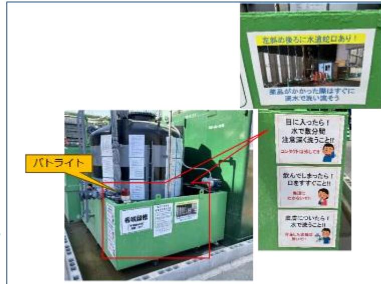
SDSの表示とは別に、応急処置の方法が一目でわかるような表示を掲示した。また、水道の蛇口の場所もわかるような表示もすることで、スムーズに応急処置が行えるようにした。また、漏出検出時の警報をパトライトとすることで認識しやすくした。
