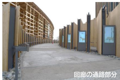
スロープ入口付近
