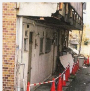
外壁剥落等の危険な状態
