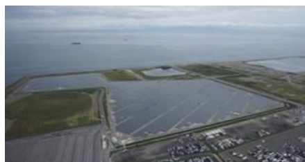
泉大津大規模太陽光発電施設
