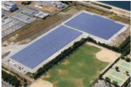
南部水みらいセンター 太陽光発電プラント
