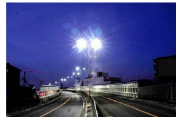
国道170号（羽曳野市内）
