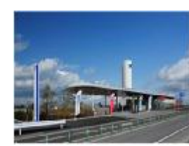
水素ステーション
