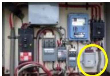
低圧分電盤内の 低圧コンデンサー
