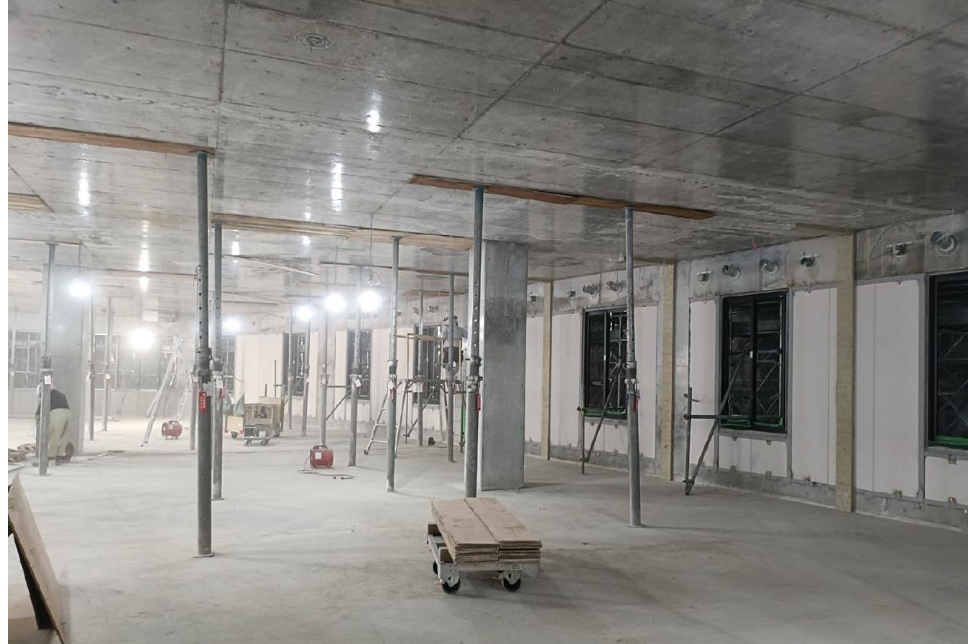
免震構造+フラットスラブでラボ計画を合理化
