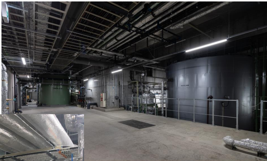
バイオガス機械室（メタン発酵槽等）
