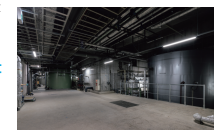
バイオガス設備機庫道(メタン発酵槽等)
