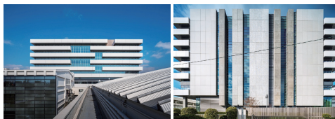
南北面：水平バルコニーによる応効果とウェルネスの両立 東西面：開口部を縦長に絞り、角度と高度の低い日射を抑制
