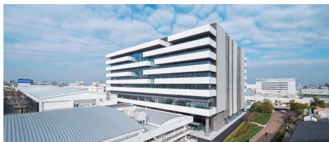
太陽の角度・高さを考慮し、南北面は水平方向、東西面は垂直方向のボリュームとし、日射制御と視界の確保を両立
