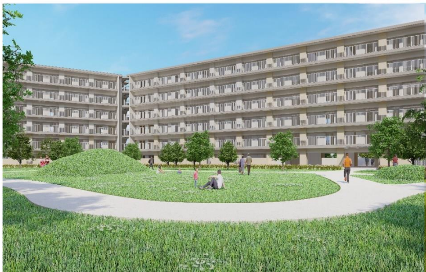
広場から住棟をみる
