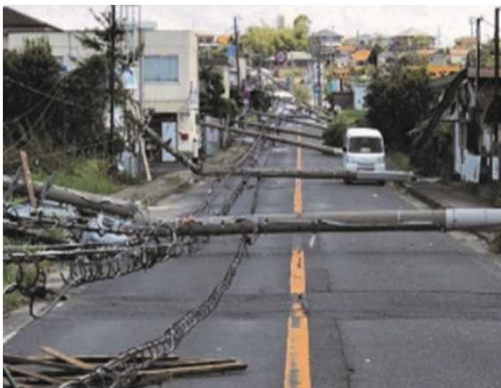
平成30年 台風21号による 電柱倒壊等による道路閉塞
