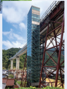
余部クリスタルタワー
