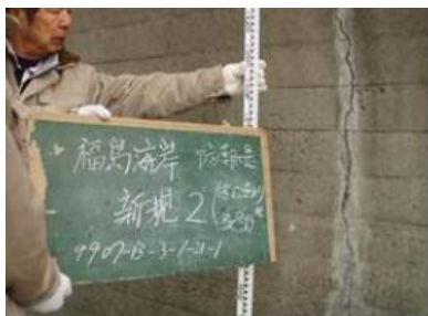
■防潮堤施設点検
