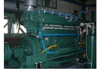
■排水機場ポンプ設備更新
