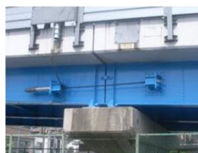
落橋防止対策
