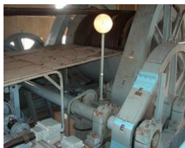
水門開閉装置更新
