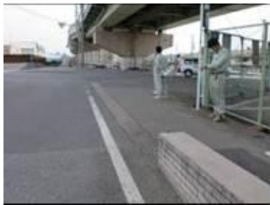
■臨港道路施設点検
