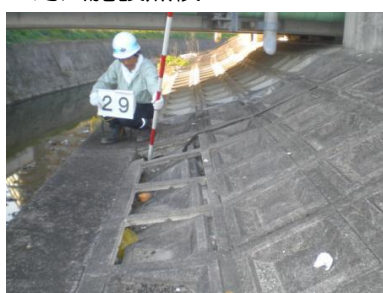
■河川施設点検
