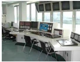
電気設備更新
