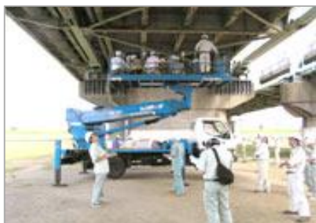
施設の定期点検
