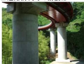
橋脚補強対策
