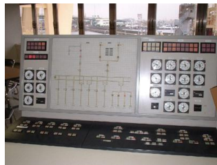
■水門電気設備更新
