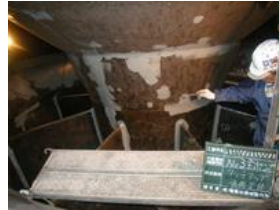
ポンプ精密点検
