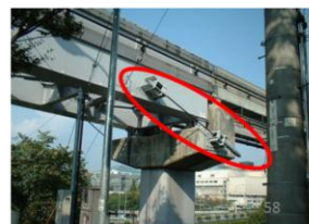
落橋防止対策
