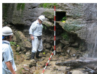
■砂防施設点検
