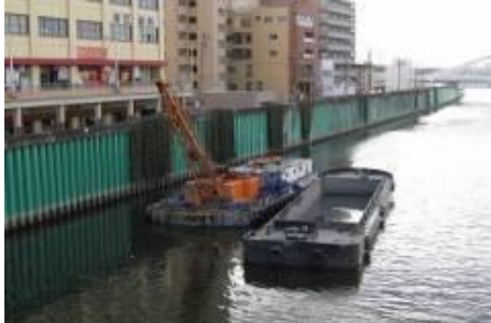
浄化浚渫（寝屋川）
