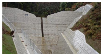
砂防えん堤の整備
