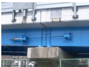
落橋防止対策
