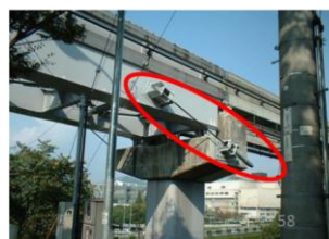
落橋防止対策
