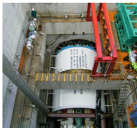
増補幹線の整備 (シールド工事)
