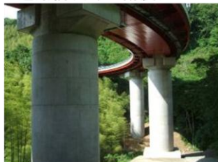
橋脚補強対策
