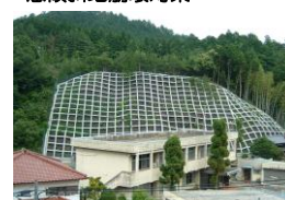
急傾斜地崩壊対策
