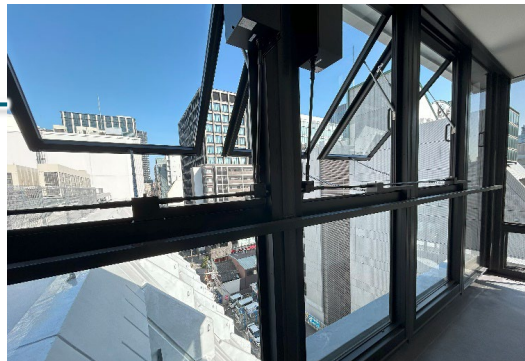
階段上部窓はFIX窓から自動開閉窓に改修し、重力換気式を実現
