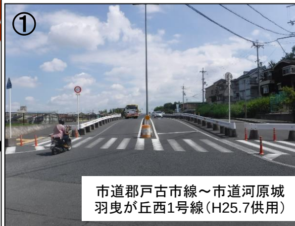
供用済み区間
