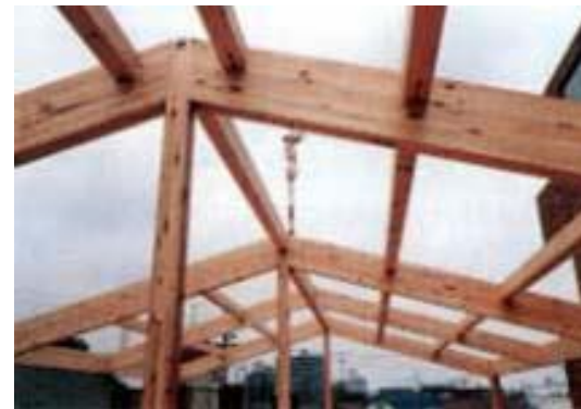
建設発生木材を特殊加工したものを用いて、住宅用構造 材等に利用することのできる木質建材を製造する技術。 (メーカー資料より引用、写真は一例)
