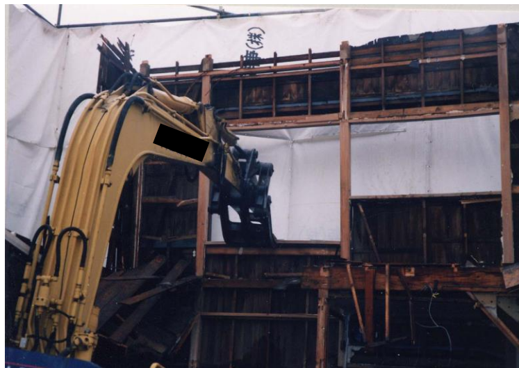
上部構造部分の取り壊し
