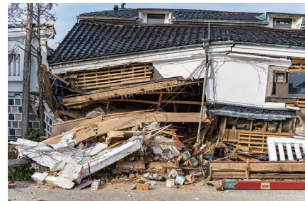
地震による被害例 (能登半島地震)
