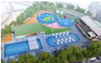
久宝寺緑地 プール再整備
