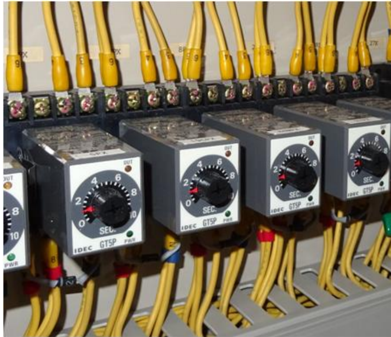
図2 給電の切り替えのための回路の動作に必要なタイマーの写真
