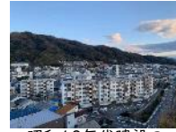
昭和40年代建設の老朽化した市営住宅
