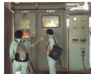
PCB 廃棄物に係る立入検査
