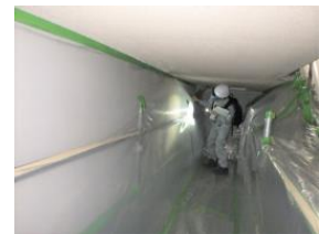
解体現場の立入調査
