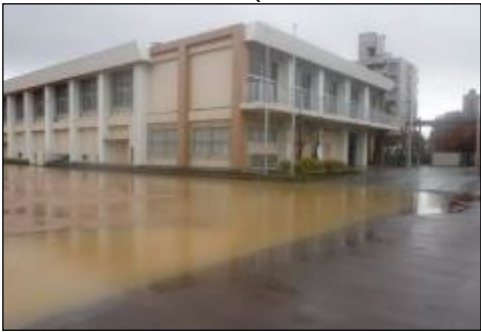
雨水流出抑制施設(市立小学校)
