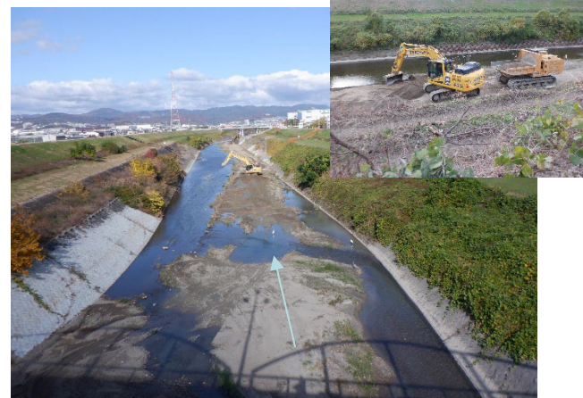
【芥川河川整備(国)の河道掘削状況】
