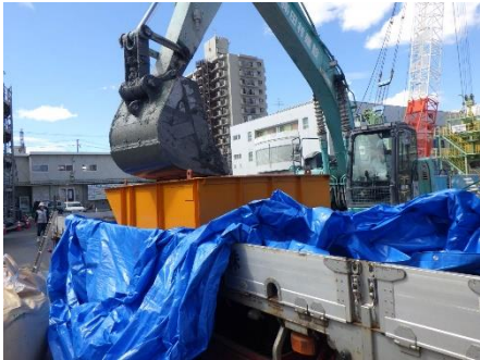
写真 1 現地発生土採取状況
