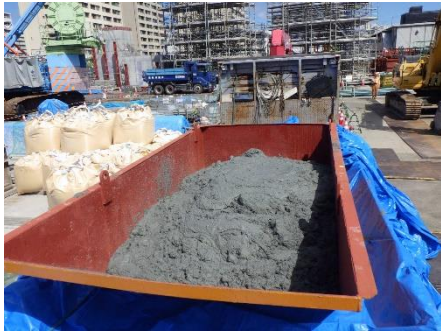
写真 1 現地発生土採取状況
