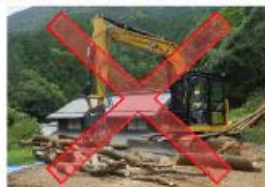
排ガス・低騒音機械確認写真
