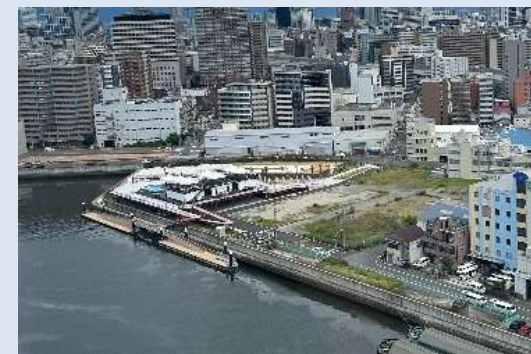
【中之島GATEサウスピア】
