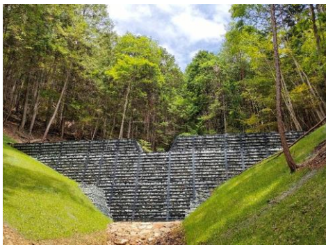
治山ダム（鋼製）の整備
