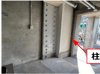
鉄道高架駅の耐震補強
