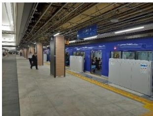
可動式ホーム柵の設置（扉式）
