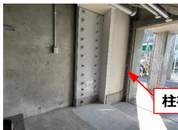
鉄道高架駅の耐震補強
