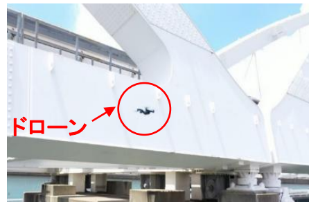
ドローンによる特殊橋点検
