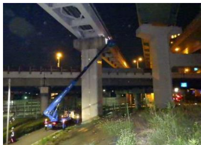
施設・設備点検の状況
