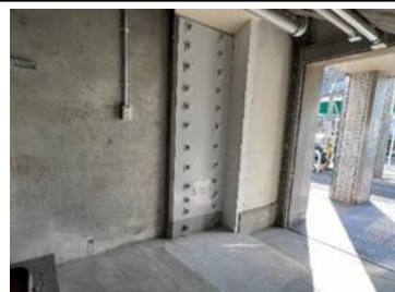
〔鉄道高架駅の耐震補強〕
