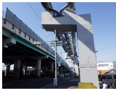
予防保全対策工事（塗装塗替）
