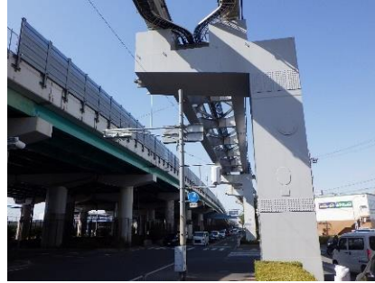
予防保全対策工事（塗装塗替）
