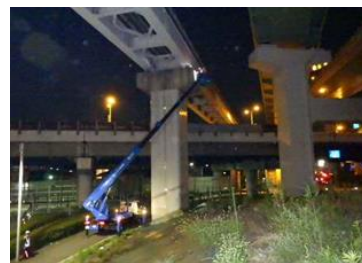
〔モノレール施設の点検〕
