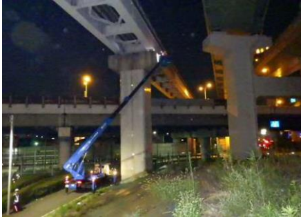
施設・設備点検の状況
