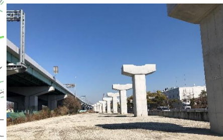
支柱建設工事（竣工後）
