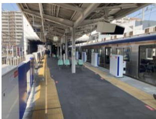
可動式ホーム柵の設置（扉式）
