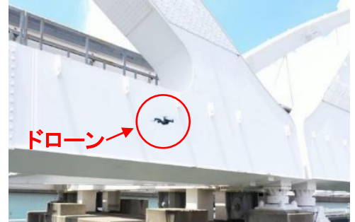
ドローンによる特殊橋点検
