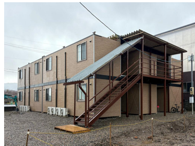
写真 ユニットハウス(能登地域)
