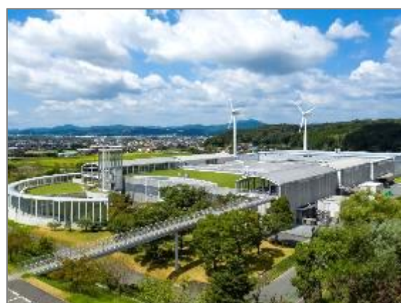
工場への 自家発電型システム
