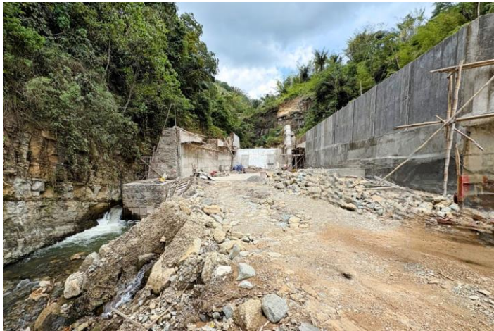
写真 小水力発電(工事中)
