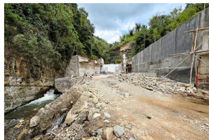
写真 小水力発電(工事中)
