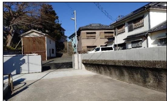
防潮鉄扉及び防潮堤
