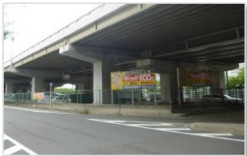
国道 423号 江坂高架橋下（吹田市）
