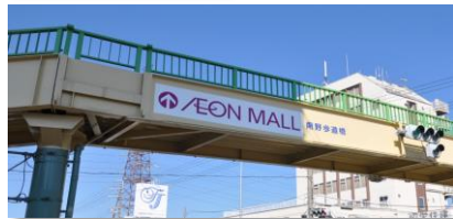
国道 170号 南野歩道橋（四條畷市）
