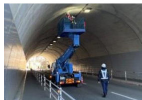
〔トンネル点検〕
