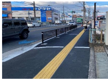
【バリアフリー化】（茨木市） （視覚障がい者誘導用ブロック設置など）
