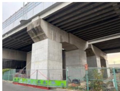
【橋脚補強】 府道 八尾茨木線 (摂津市)
