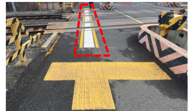
【踏切内の誘導用ブロックの設置】 （和泉市）
