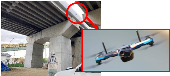
ドローンを活用した橋梁点検
