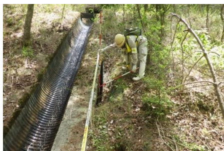
【道路法面对策】 一般国道173号 (豊能郡能勢町)
