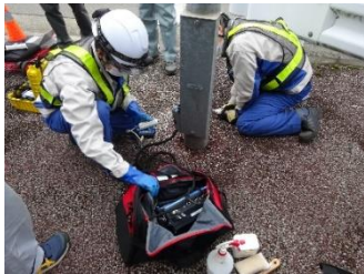
照明柱の非破壊調査
