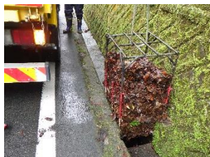
道路施設の清掃
