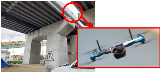
ドローンを活用した橋梁点検
