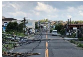
倒壊による道路閉鎖
