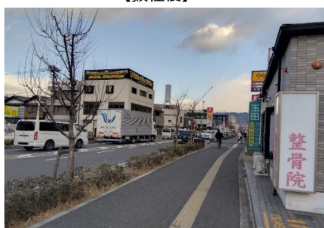
【無電柱化の事例】大阪港八尾線（八尾市）
