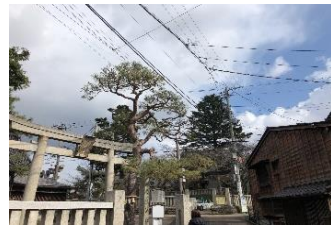
電線による景観阻害
