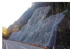
〔道路法面对策〕
