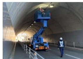
〔トンネル点検〕
