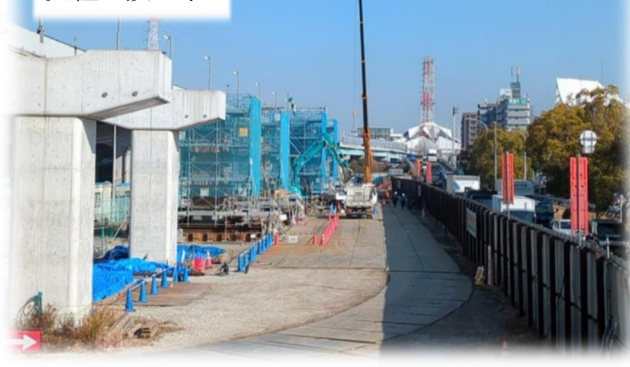
支柱建設工事
