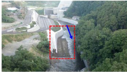
図 1-44 置き土の施工位置
