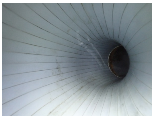
管更生後の管内写真
