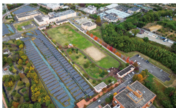
狭山水みらいセンター
