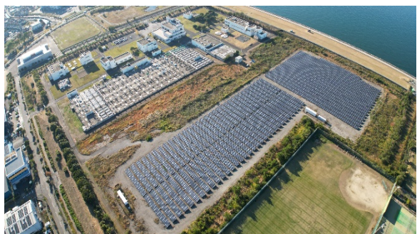
南部水みらいセンター
