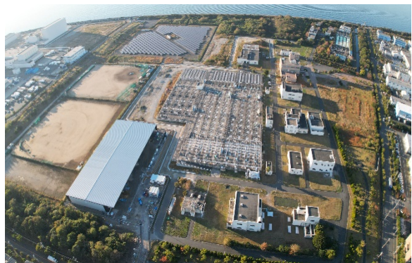
中部水みらいセンター
