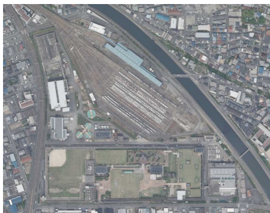
川俣水みらいセンター
