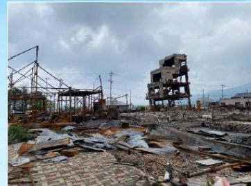
2024.1.1 能登半島地震／輪島市朝市通り
