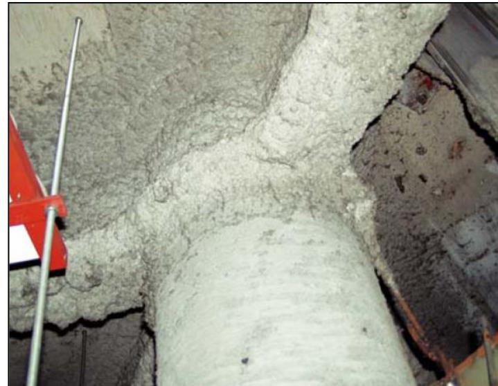
耐火被覆用として石綿吹付け材が多用され、1963（昭和38）年ころから1975（昭和50）年初頭までの建築物に多い。その後、ロックウール吹付けが主流となるが、1980（昭和55）年ころまでは0.1%以上の石綿が含有されていた。
