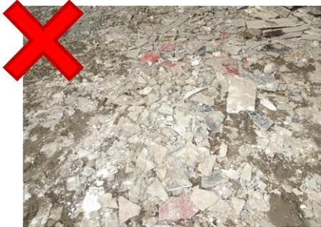
レベル3建材の破片が重機で踏まれてさらに破断していく
