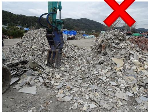
レベル3建材が重機で破碎されている
